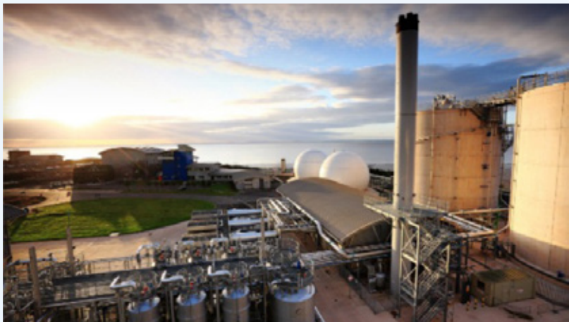
Safle treulio anaerobig a hydrolysis thermol mewn Gwaith Trin Dŵr Gwastraff yng Nghaerdydd.
